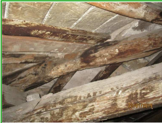
Riduzione dei sezione, umidità e funghi - Zona A2
