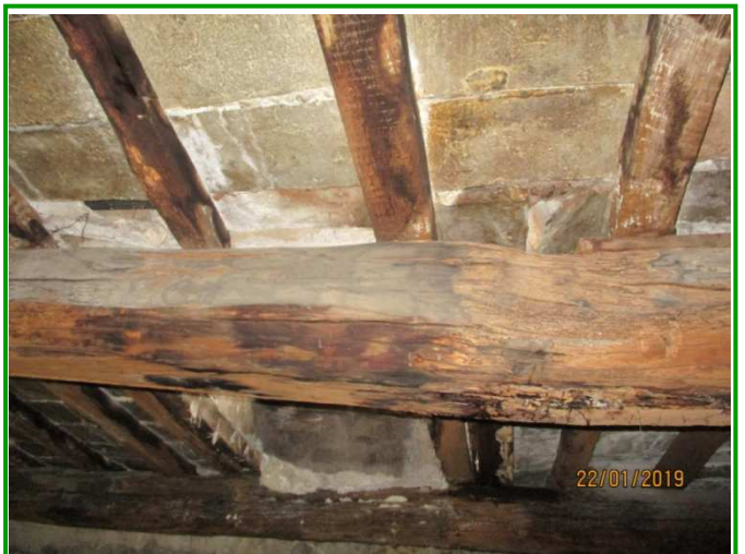
Ammaloramento travi e cedimento solaio - Zona A2
