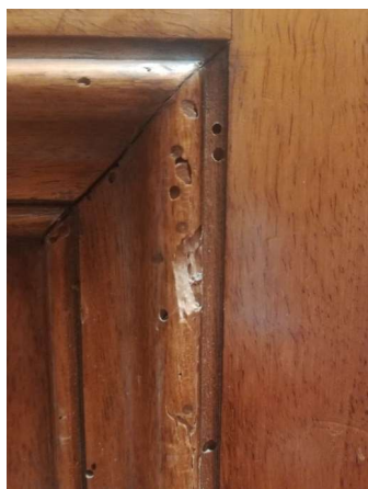
Fig. 1 – Palazzo Ossoli – infissi interni in legno degradato
