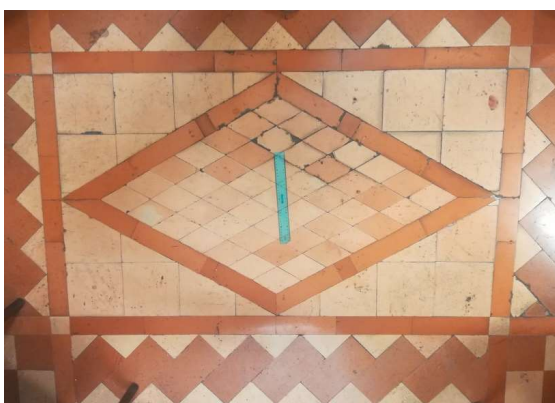
Fig. 4 – Palazzo Ossoli – pavimentazione ambiente C2 piano primo
