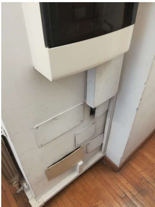
Foto n.29 – impianto elettrico fuori traccia piano primo
