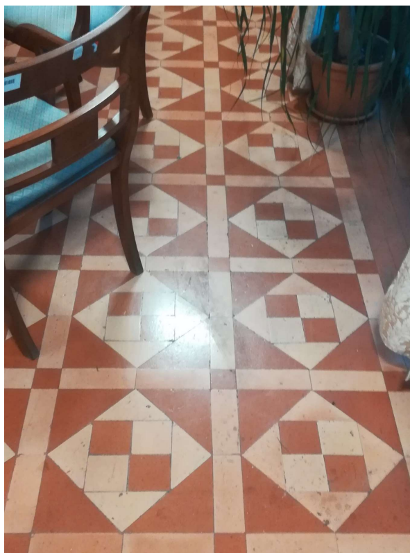
Fig. 9 – Palazzo Ossoli – pavimentazione di mattonelle con decori geometrici ambiente 8 piano primo
