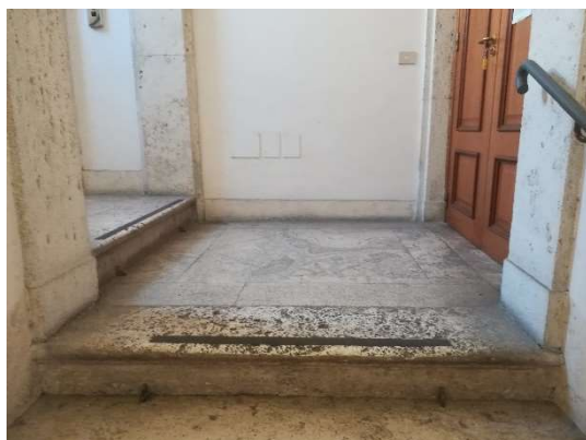
Fig. 12 – Palazzo Ossoli – dislivelli pianerottolo sbarco ascensore piano primo
