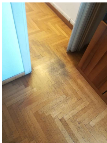
Fig. 11 – Palazzo Ossoli – pavimentazioni in parquet a spina di pesce diagonale piano terzo
