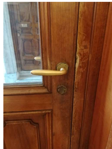
Fig. 1 – Palazzo Ossoli – infissi interni in legno degradato
