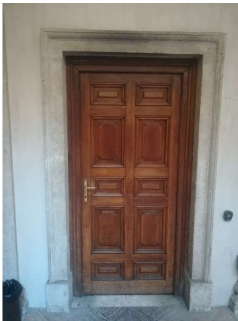
Fig. 2 – Palazzo Ossoli – infisso interno in legno con finitura trasparente
