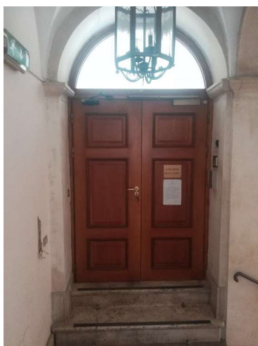
Fig. 14 – Palazzo Ossoli – dislivello pianerottolo piano secondo
