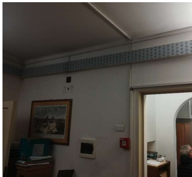
Foto n.30 – impianto elettrico fuori traccia piano terzo
