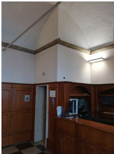
Fig. 13 – Palazzo Ossoli – sbarco ascensore piano terra
