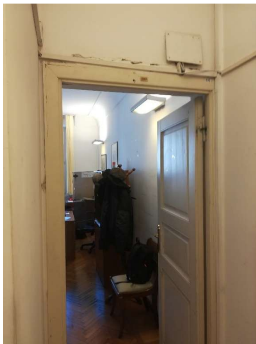
Foto n.29 – impianto elettrico fuori traccia piano primo
