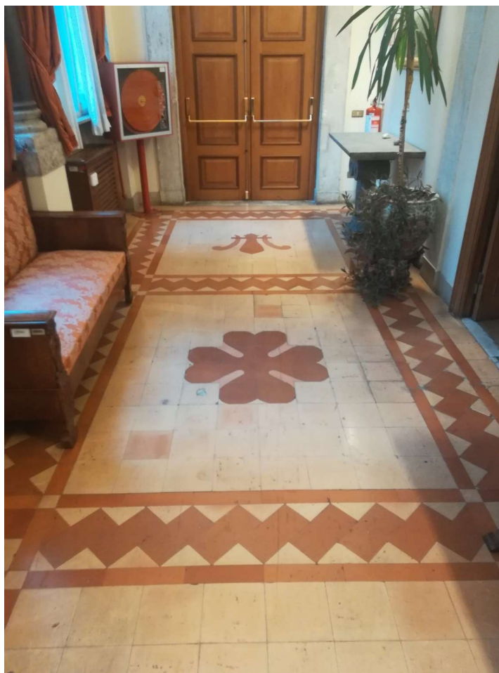
Fig. 5 – Palazzo Ossoli – pavimentazione ambiente C1 piano primo
