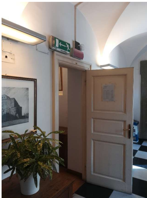
Fig. 3 – Palazzo Ossoli – infisso interno in legno con finitura in smalto
