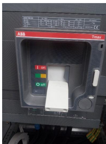
Interruttore a bordo macchina gruppo elettrogeno
