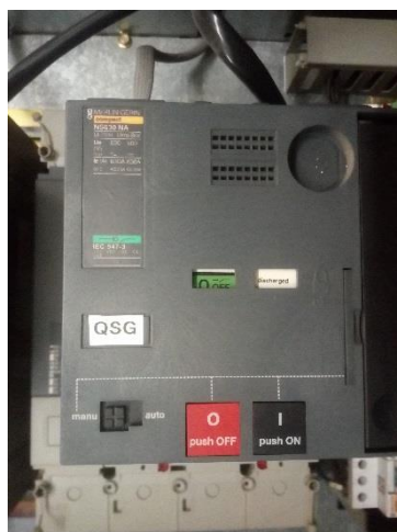
Interruttore a bordo macchina gruppo elettrogeno
